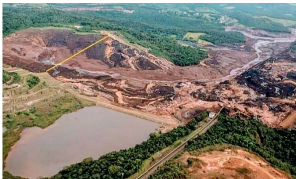
Выброс хвостов обогащения руды после разрушения дамбы хвостохранилища
