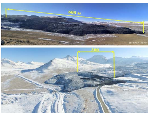
Техногенный оползень, на отвалах высокогорного рудника Кумтор (2019 г)
